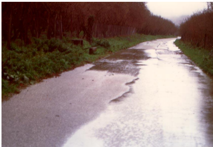
Fig. 7.3: Episodi di deflusso sulle strade a seguito di un evento del novembre 1997.
